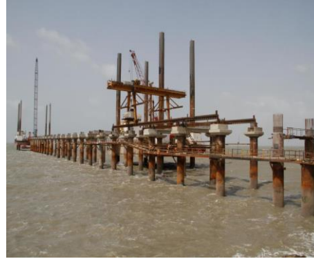
LNG – Precast Erection Gantry
